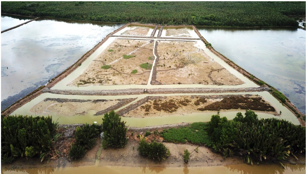
Gambar 23. Kondisi tambak setelah dilakukan konstruksi galian saluran
