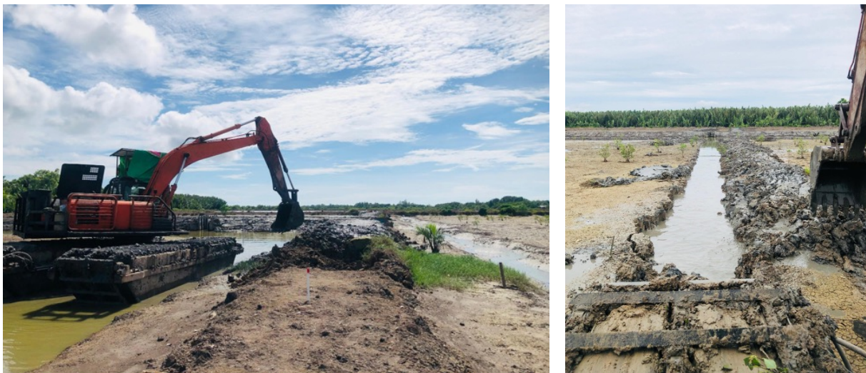
Gambar 21. Pekerjaan Saluran Sekunder dengan Excavator
